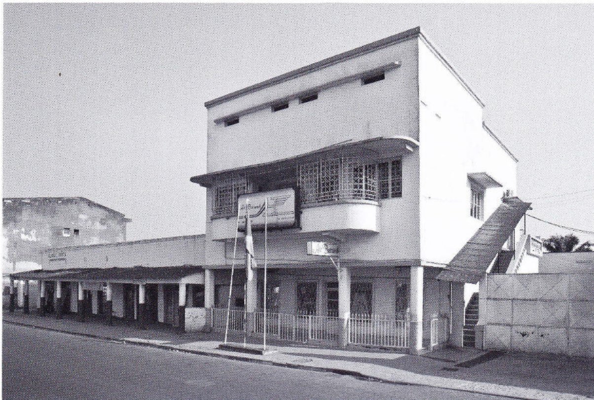
Air Burundi , avenue du Commerce, Bujumbura, begin jaren 1950, woning en winkel, nu kantoorgebouw
