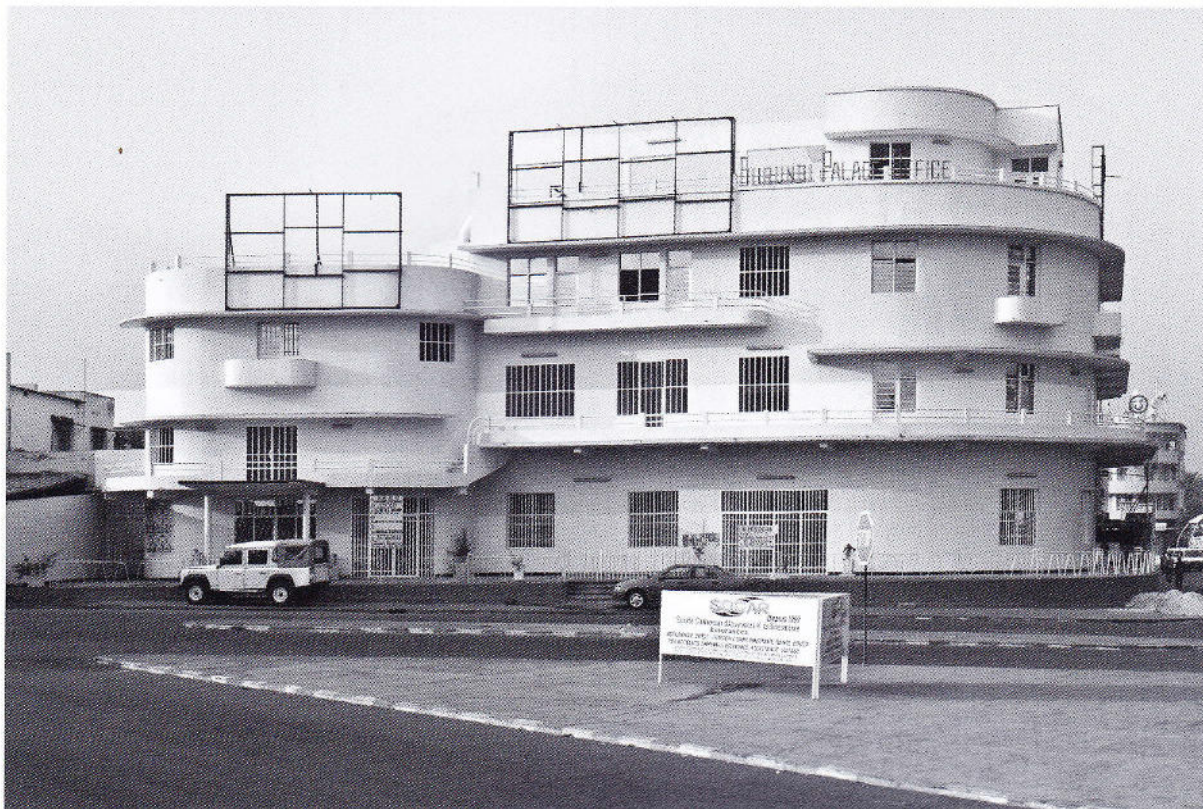
Burundi Palace Office van de heer Ephripedes, kruispunt boulevard de l'Uprona en chaussée du Peuple Murundi, Bujumbura, eind jaren 1940, eerder Grand Hôtel en Palace Hôtel , gerenoveerd in 2008-2009
